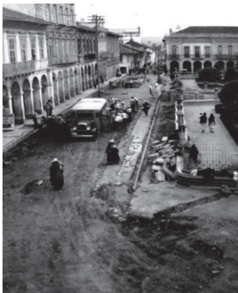
Hacia 1937 se cerró las acequias de las calles que empezaron a pavimentarse con adoquines. Se ve las obras en la calle Bolívar, frente al parque Calderón.
