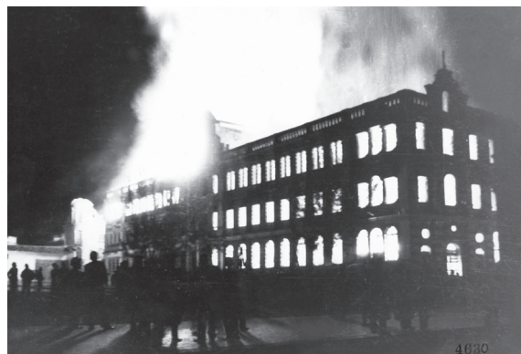
Un voraz incendio consumió el edificio de la comunidad salesiana, el 19 de julio de 1962, en la plaza María Auxiliadora.
